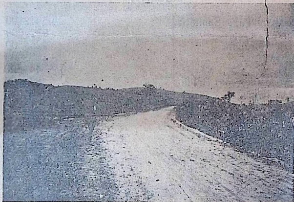
Trcho do 3º. kilometro da estrada de ligação Rezende S. Paulo-Rio, mostrando uma bella tangente de mais de 600 metros, após uma curva de 200 metros de raio, sendo de notar que, nos primeiros 10 kilometros, o menor raio de curva é de 100 metros, e a maior rampa, 4 %.
